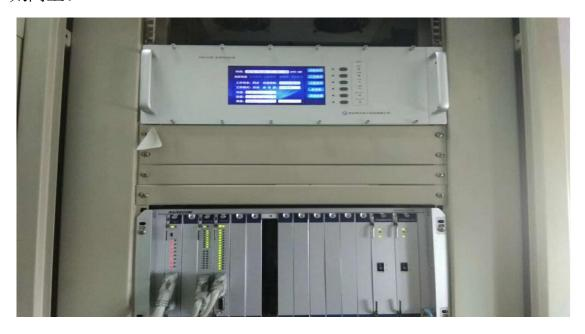
北斗网络校时服务器整体系统的构建一点也不复杂,但要前提 校时服务器要保证达到较高的授时精度不仅需要对网络时延估计进 行深入的分析和研究,而且也会认为建立一个准确的网络校时服务 器的网络授时体系也是非常必要的,将数个时间服务器在不同的区 域进行合理分布,能有效保证各个系统之间的时间准确性。随着信息 产业的不断发展,高时间约束业务对时间同步的要求越来越高,网 络授时技术的应用也将越来越广泛。
