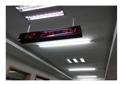
在整体设计上,本着"可靠、实用、先进、经济,易维护扩展"的原则进行选择的是一套 ntp 网络对时系统。整个系统是由 GPS 和北斗双模授时天线,对时服务器(母钟)、子钟及交换机组成。对时服务器选用的是 SYN2136型,输出 2路 ntp 网口,达到冗余备份,配备避雷器;子钟选用的是 SYN6109型网络子钟系列中的 3 英寸时分秒子钟,这次配置子钟共计 80 台。整个学校的时钟系统有以下特点:
